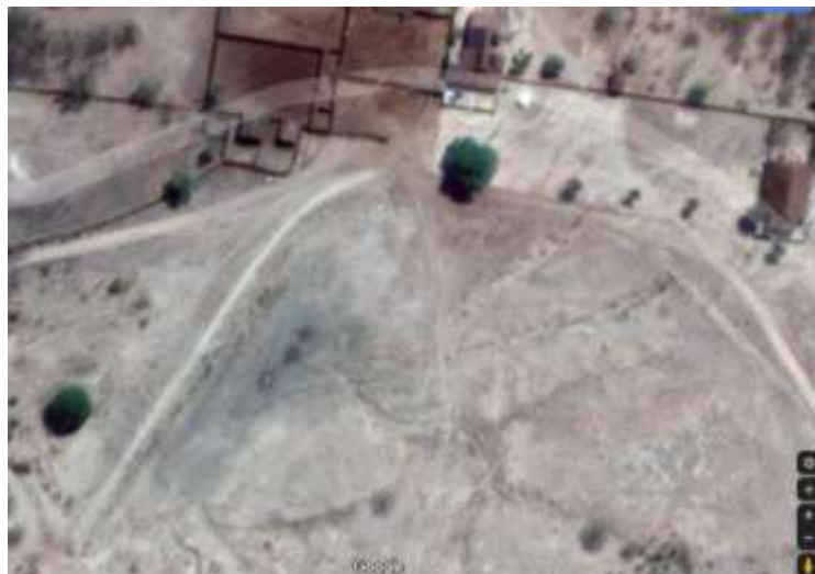
Figura 5 - A barragem de salvação vista de cima.
