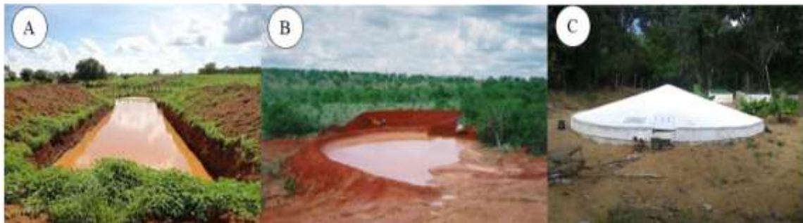
Figura 3: a) Barreiro – trincheira b) Barraginha c) Cisterna de enxurrada
