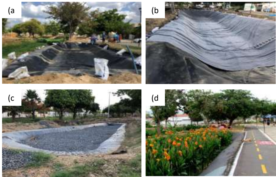
Figura 5 - Sequência de execução de um SAC do riacho Pajeú: (a) Geomembrana; (b) Geotêxtil; (c) Substrato; (d) Macrófitas.
