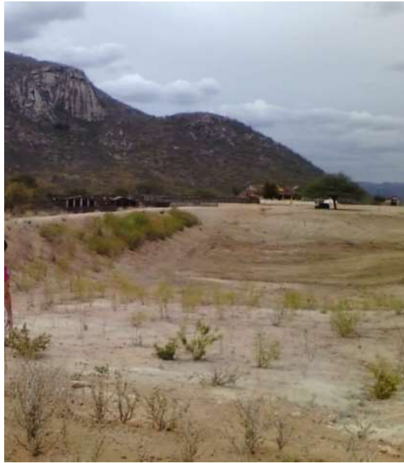
Figura 4 - Barragem de salvação totalmente seca.
