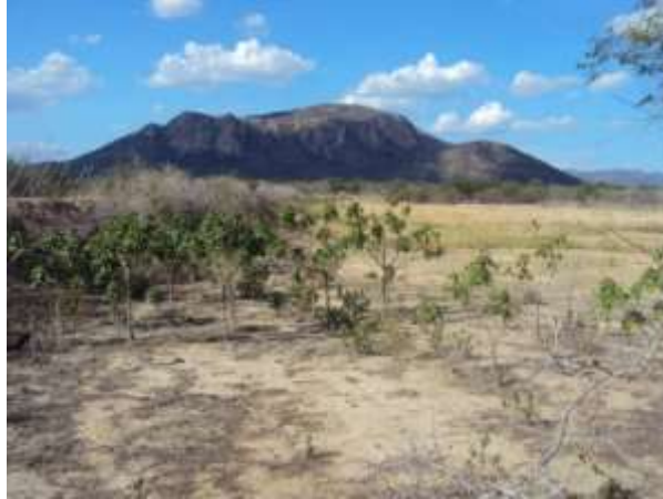
Figura 11 – Árvores e arbustos no talude de montante da barragem.
