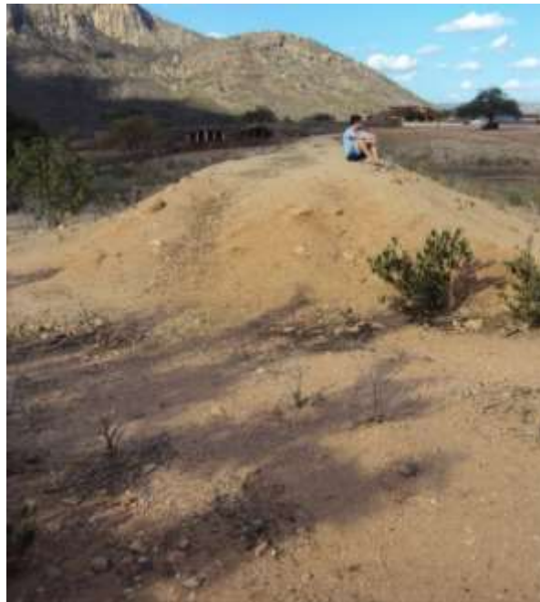
Figura 10 - Sangradouro da barragem com nascimento de vegetação.
