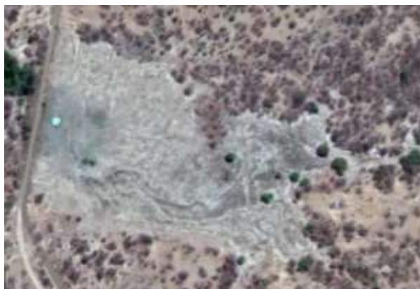
Figura 13 – Pequena barragem de terra vista de cima.
