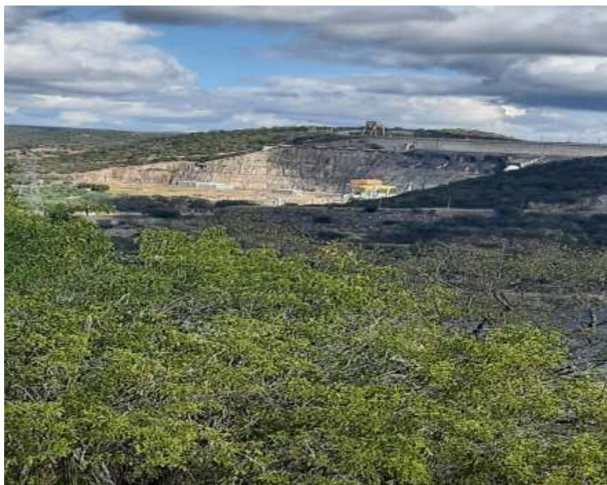
Figura 02: Trecho da Usina Hidrelétrica de Xingó, situada entre os municípios de Canindé de São Francisco – SE e Piranhas – AL.
