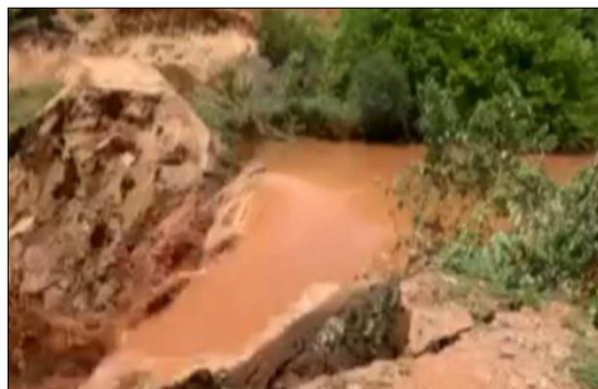
Figura 7 – Erosão gera rompimento de barragem na zona rural de Farias Brito (CE), em março de 2023.
