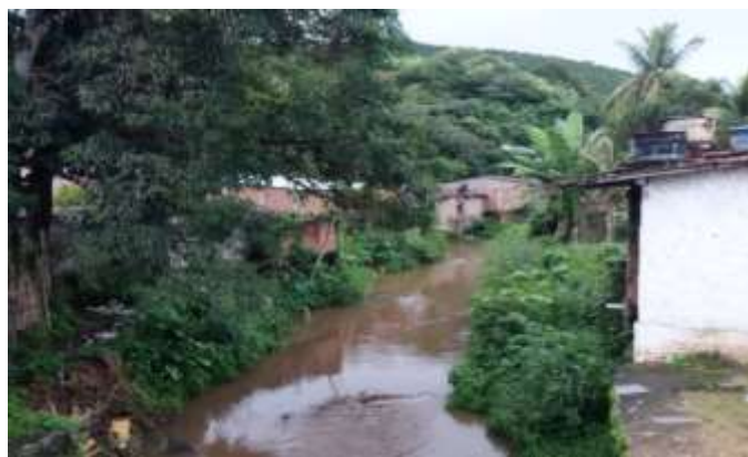
Figura 2 – Rio Branca contornando por trás das residências da rua Prado Omena
