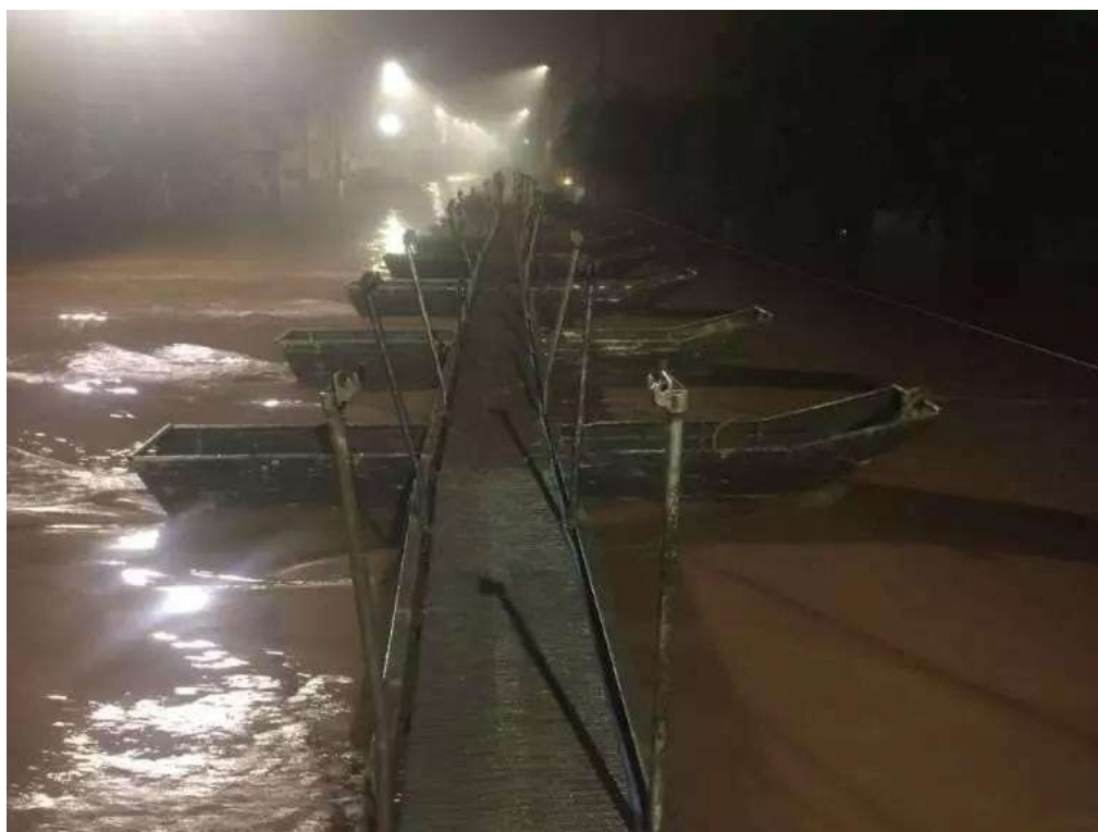
Figura 3 - Passadeira construída na entrada da ponte nova.
